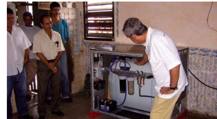
Installation von solaren Trinkwasserreinigungsanlagen für die voruniversitäre landwirtschaftliche Projektpartnerschaftsschule Alvaro Barbo Machado in der Stadt Camagüey.
